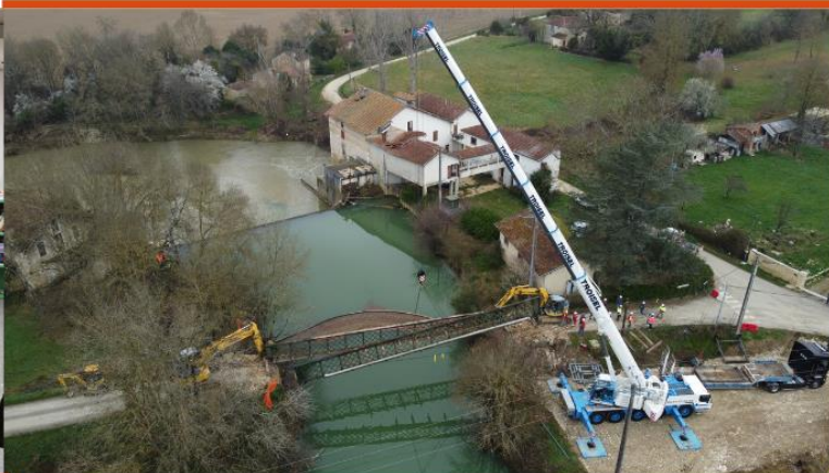
Démolition du Pont de Beaucaire Février
